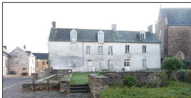
L'ancien presbytère en quête d'une nouvelle vocation
