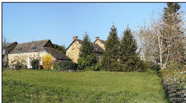
Corps de ferme rue de Blossac
