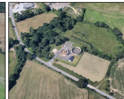
La station d'épuration à Bois Martin
