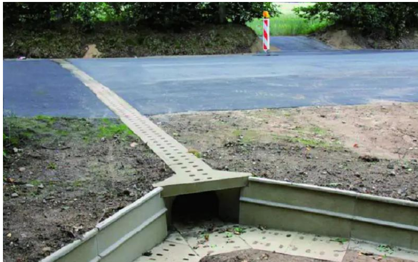
Exemple d'un crapauduc (Source : ACO)
