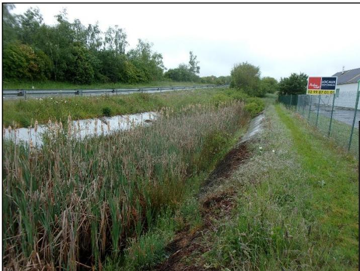
Photo du bassin d'orage aval de la ZA La Corbière et de son ouvrage de sortie
