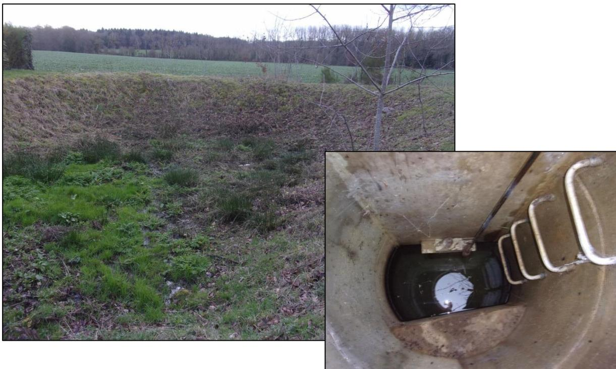
*Photo de l'ouvrage de sortie et du bassin d'orage à sec du lotissement « Le Clos des Tilleuls »*
